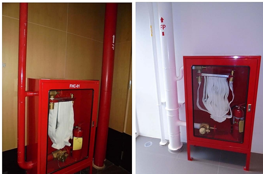
ภาพที่ 3-18 ตู้เก็บสายฉีดน้ำดับเพลิงพร้อมอุปกรณ์
