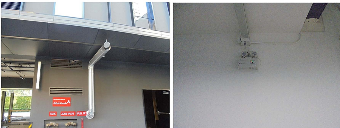
ภาพที่ 3-17 หัวรับน้ำดับเพลิงจากภายนอกโครงการ และไฟฟ้าส่องสว่างฉุกเฉิน
